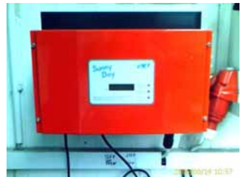
Bild 3: Beispiel eines Wechselrichters
